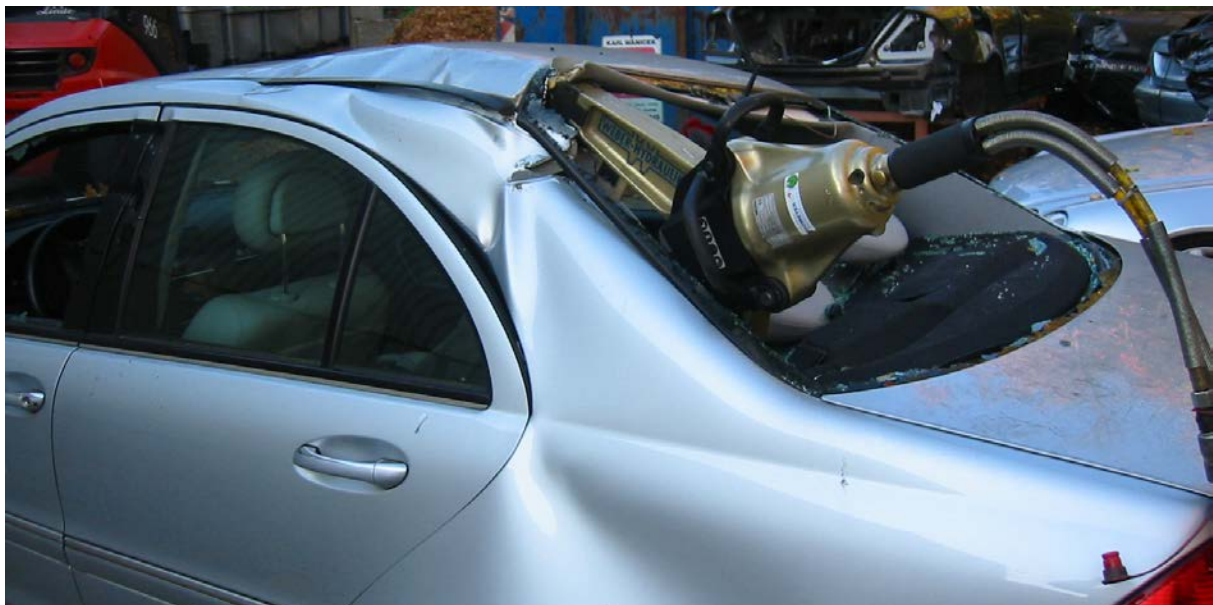
Figuur 31: Deze foto toont een voorbeeld van een methode om snel een doorgang te creëren via het achterraam. In plaats van gedeeltelijke of complete verwijdering van het dak kan de achterraamopening vergroot worden met behulp van de spreider door het dak omhoog of de hoedenplank naar beneden te drukken.
