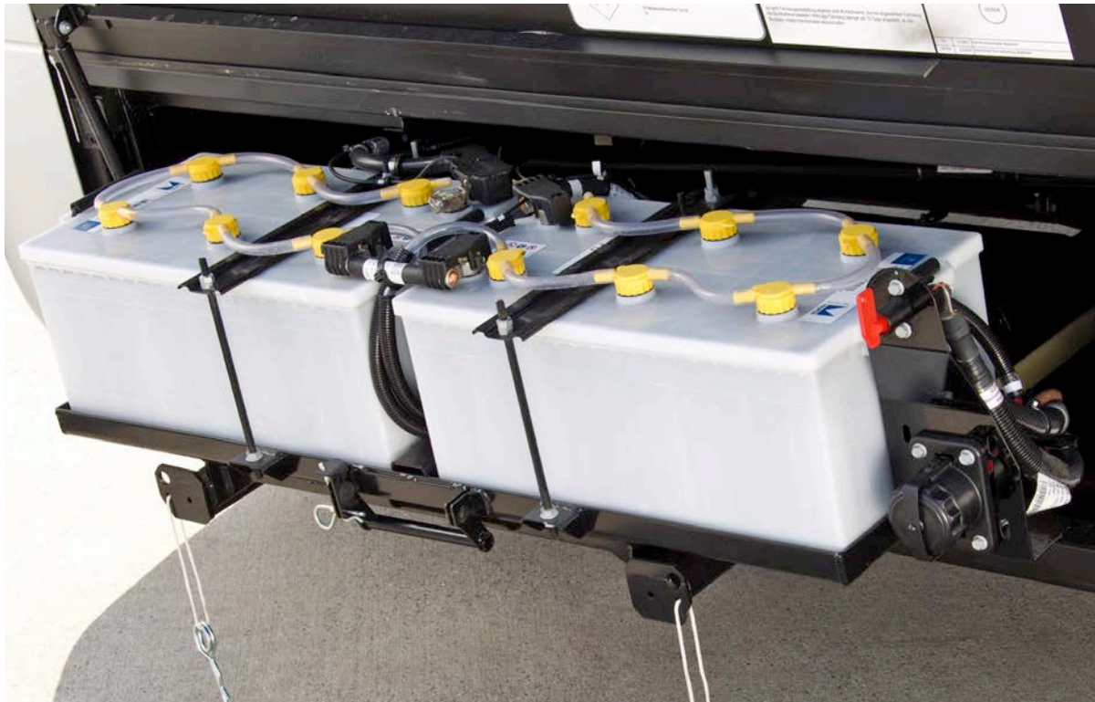
Afbeelding 25: bij bussen zijn in de regel twee 12-volts accu's in serie geschakeld. Ze bevinden zich vaak in van buitenaf toegankelijke accuvakken. Vaak is ook een accuhoofdschakelaar aanwezig. (Foto: Evobus GmbH)
