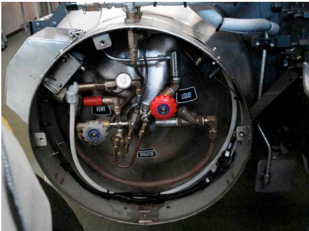
Afbeelding 30: armaturen bij een cryogene tank voor LNG. Naast de beide mechanische blokkeerventielen zijn ook de beide overdrukventielen te herkennen (opschrift: Vent). Het primaire overdrukventiel is aangesloten op de ventilatieleiding, het secundaire overdrukventiel (rode kap) voert LNG direct in de buitenlucht. (Foto: Volvo Trucks)
